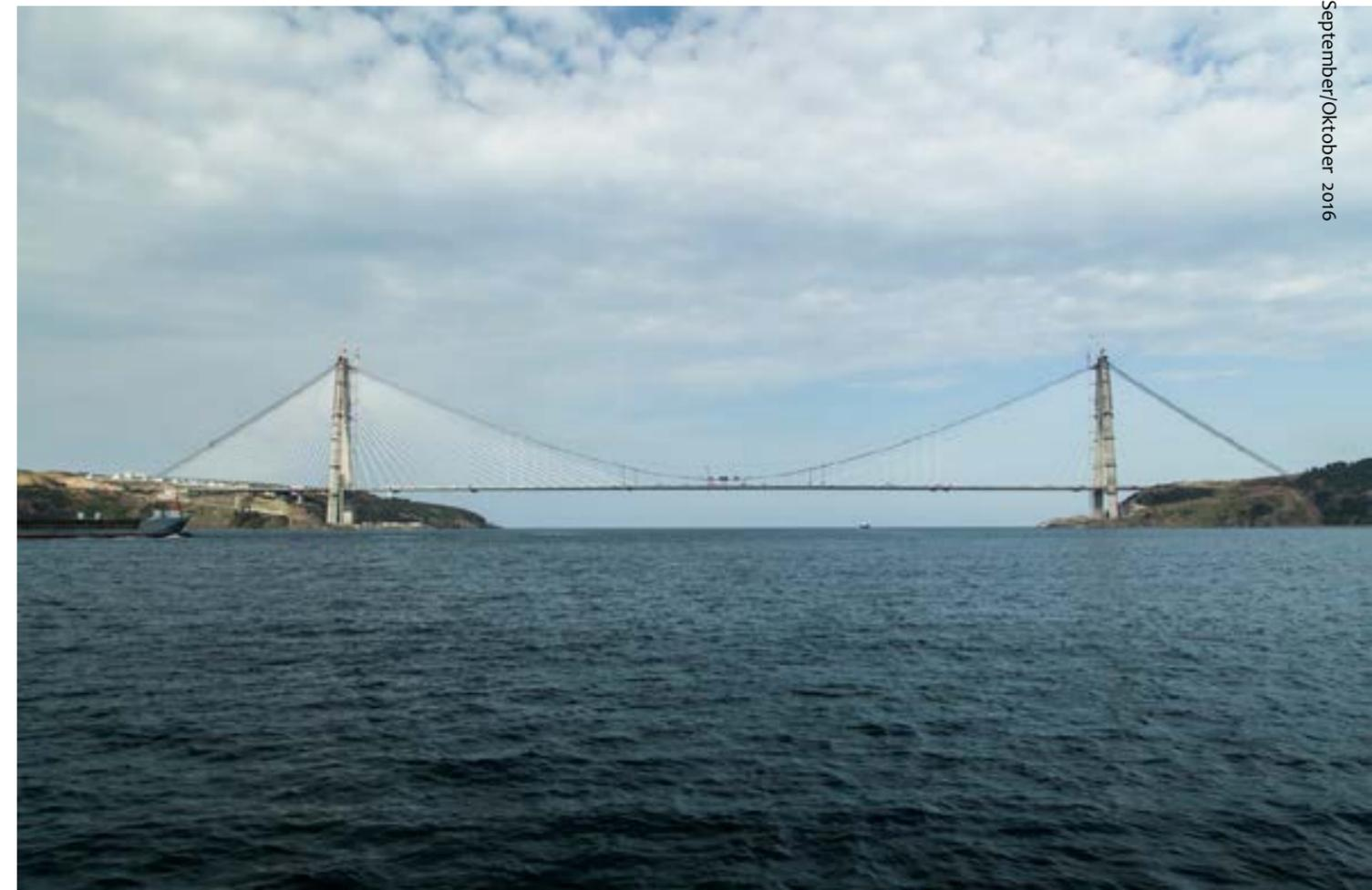
gewicht von 2,4 Tonnen aus, besteht die Brücke aus 696.000 Tonnen Beton. Die Brückenpfeiler wurden in 21 Etappen betoniert.
